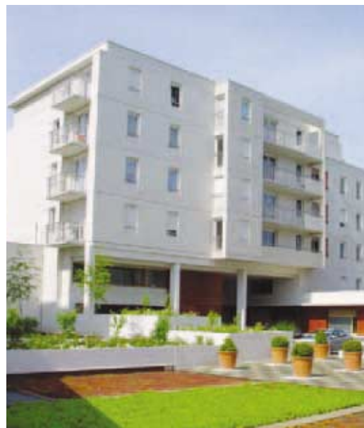
LFE – Résidence de l'Alandier à Evreux
