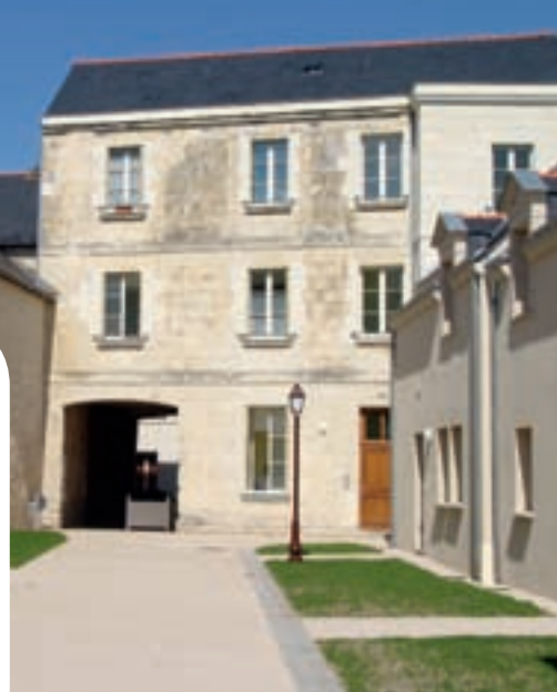
Réhabilitation d'un immeuble de logements sociaux à Longueville
