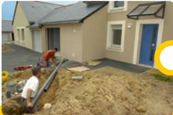
Construction de 14 logements à Baugé - Habitat 49
