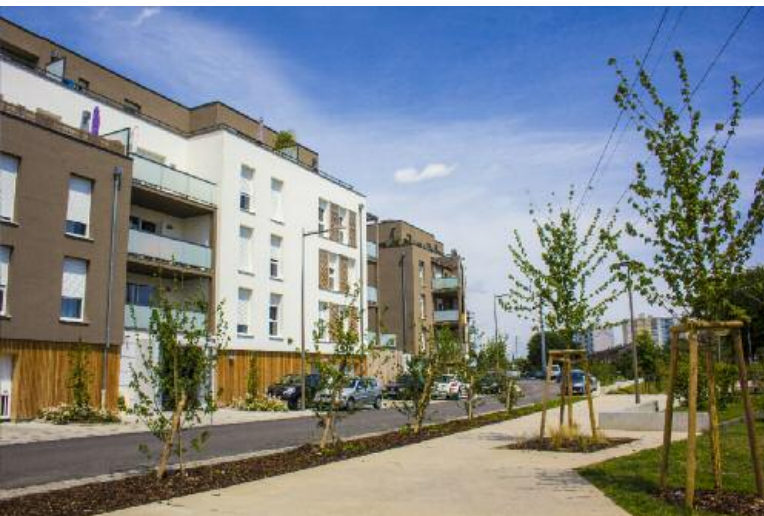
Construction de 250 logements, lotissement du Lac à Lingolsheim, © Ville de Lingolsheim, 2013
