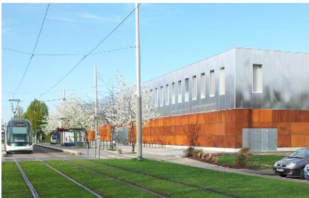
Pépinière d'entreprises de Hautepierre, © P. GSTYR, 2015
