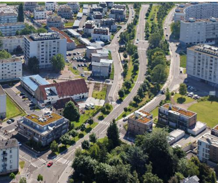
Vue du Cours de la Forêt et des nouvelles constructions situées en face du Marschallhof. Constructions de 26 logements par CUS-Habitat, allée Jacqueline-Auriol, ©MRW Zeppeline, 2011
