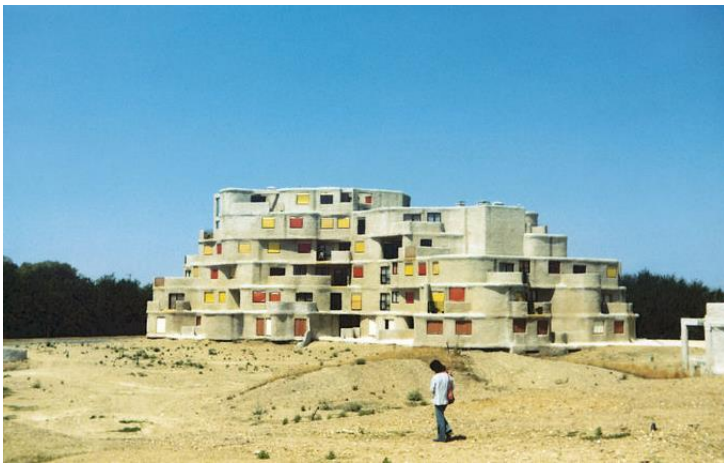
Opération de 220 logements de Vladimir Kalouguine à Angers, 1975
