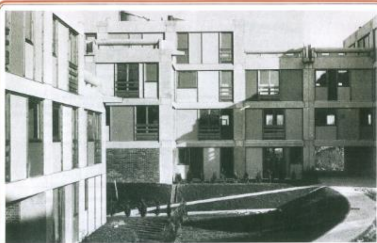
Les éléments entourent un jardin intérieur. La structure est existante ; les cheminements pilotes traversent les constructions. De nombreux appartements ont une terrasse.
