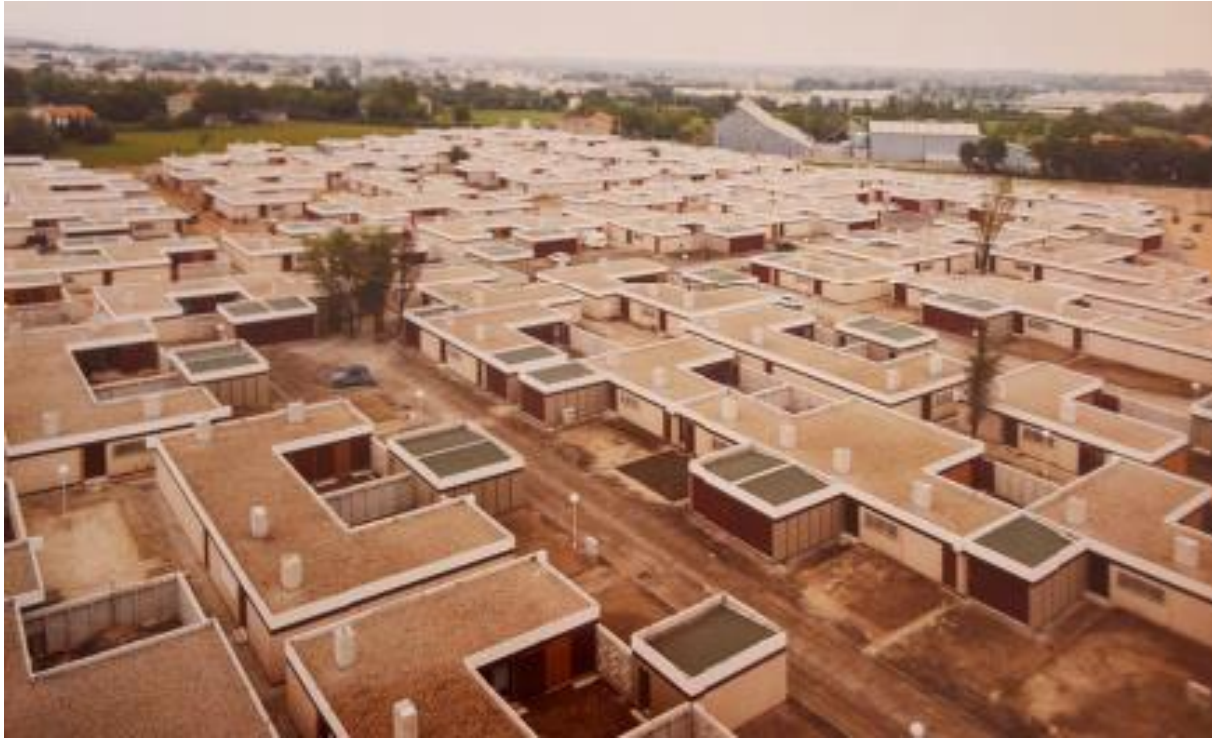
Lotissements Les Flamands et les Aigrettes, Arles, 1971-1973, Mario Fabre, architecte.
