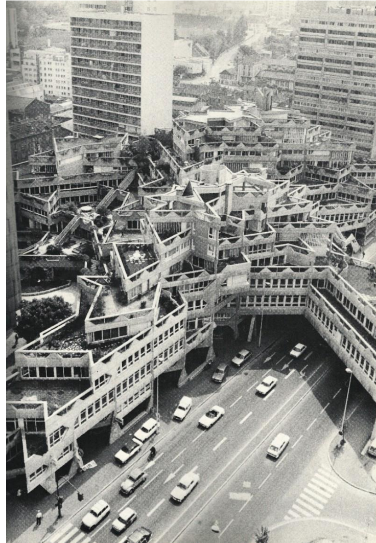
Jean Renaudie, Les Étoiles, rénovation du centre d'Ivry-sur-Seine, (1970-1975)
